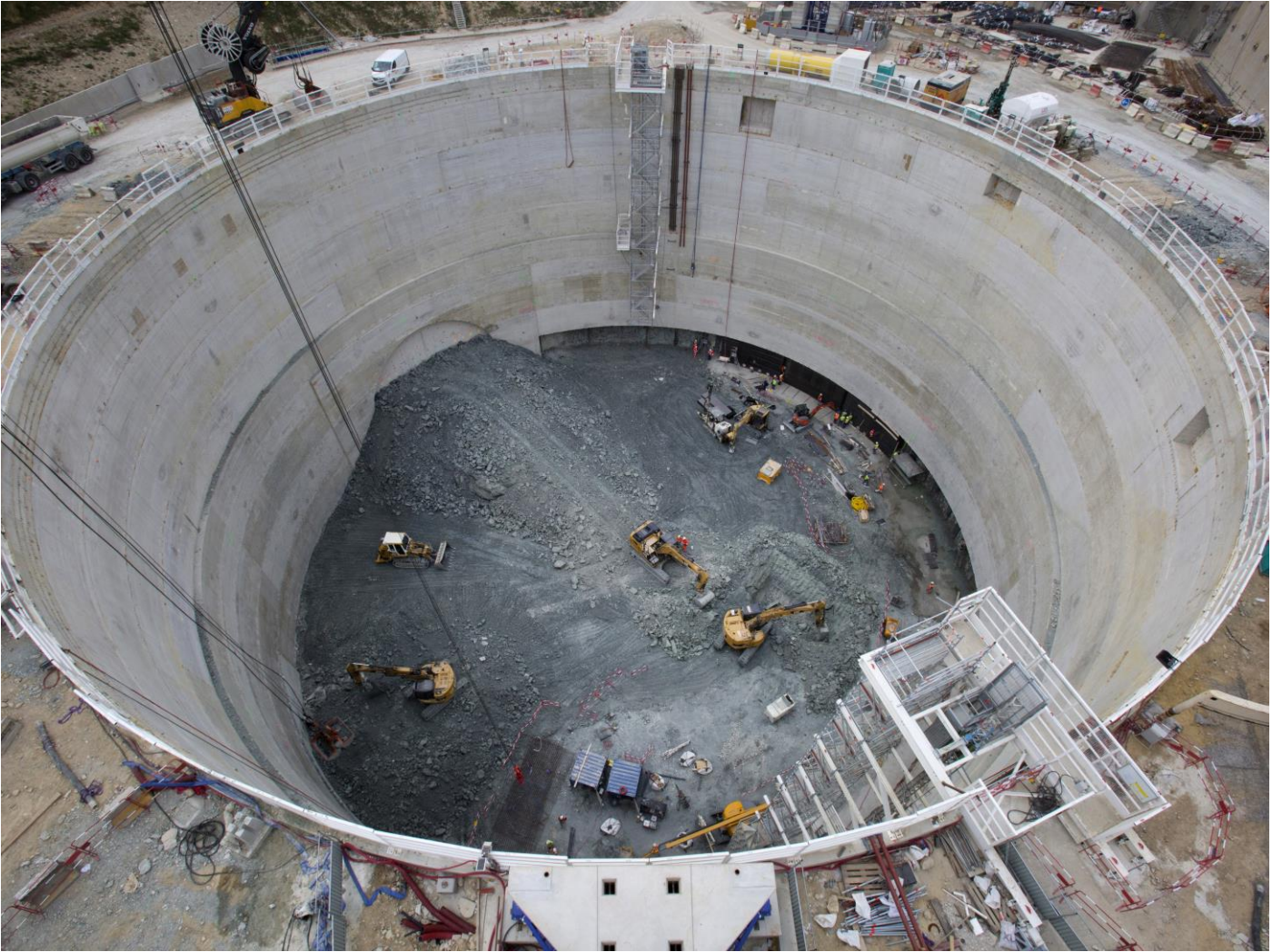
Chantier de la gare Villejuif Institut Gustave-Roussy
